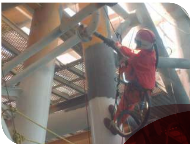
TRABAJOS DE BLASTING
