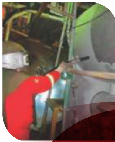
Limpieza abrasiva con esponja de baja producciones polvo
