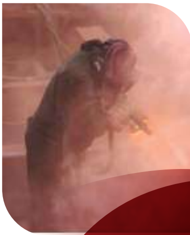
Limpieza convencional con chorro abrasivo
